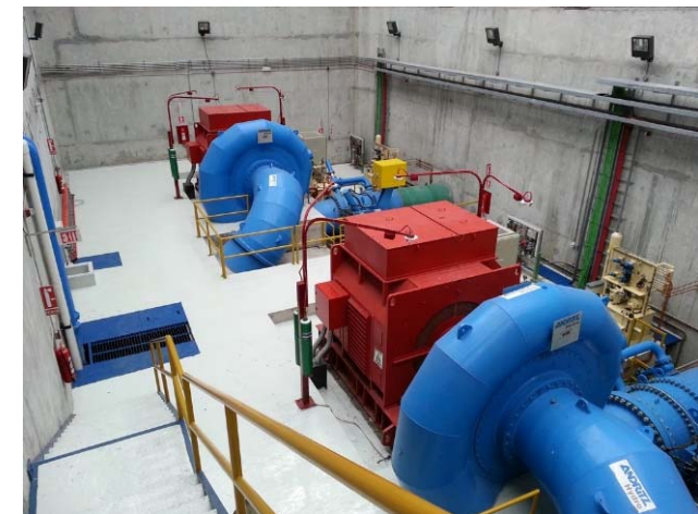
Casa de máquinas Cochea
