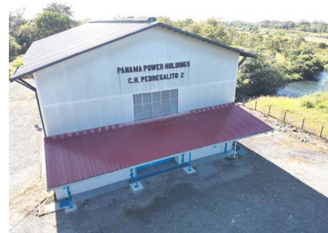
Casa de máquinas Pedregalito 2
