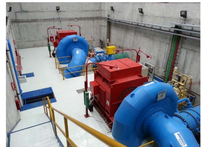
Casa de máquinas Cochea
