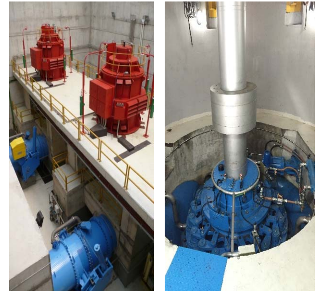
Casa de máquinas Pedregalito 2
