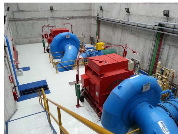
Casa de máquinas Cochea
