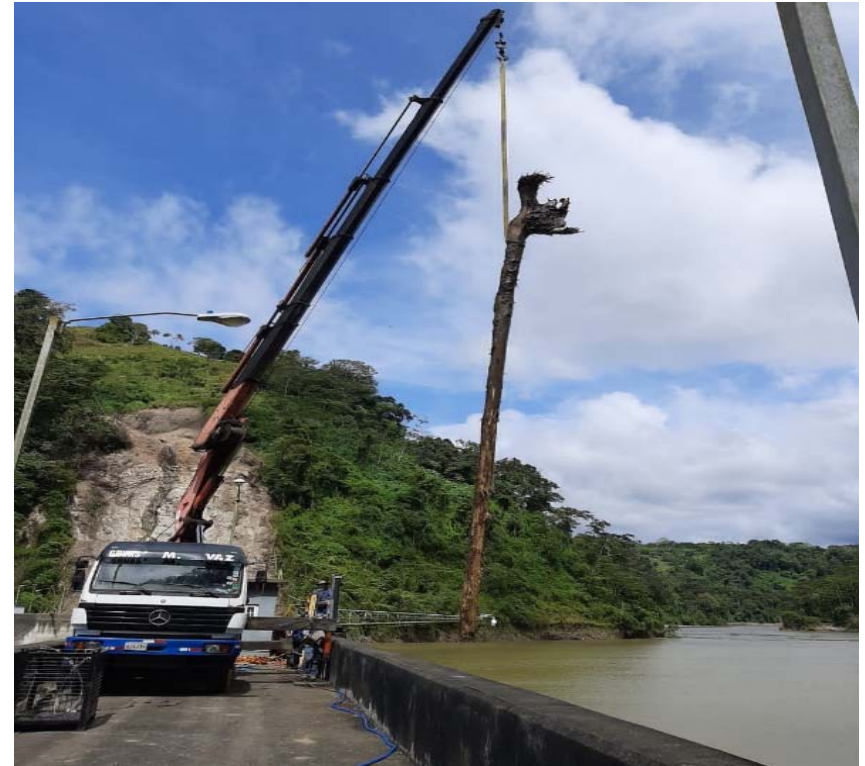
Limpieza de obstrucciones y sedimentos en el embalse
