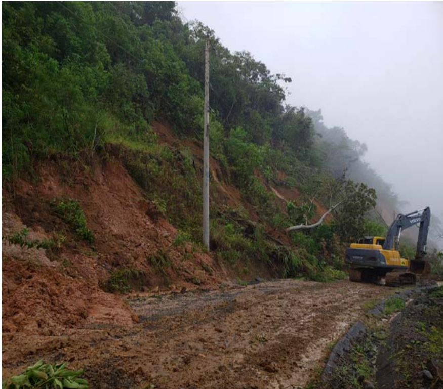
Trabajos en camino de acceso
