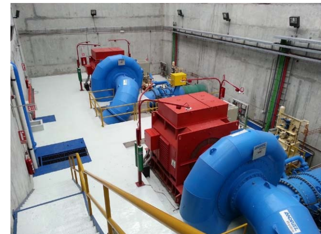
Casa de máquinas Cochea
