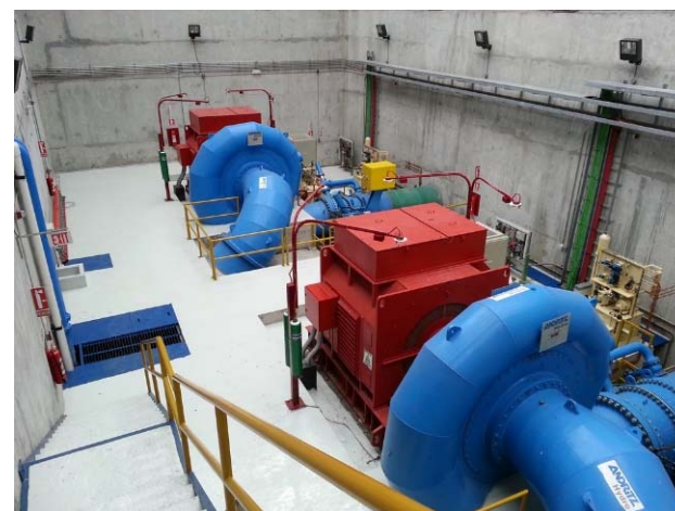
Casa de máquinas Cochea
