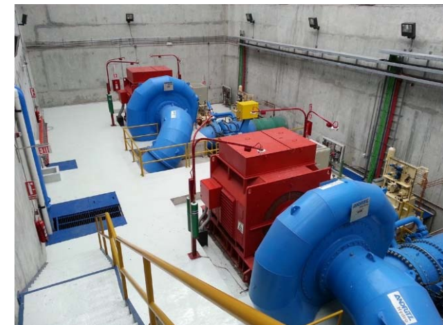
Casa de máquinas Cochea
