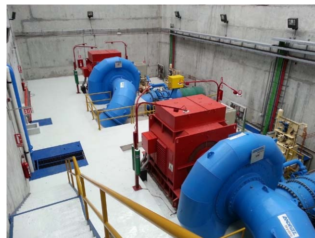
Casa de máquinas Cochea
